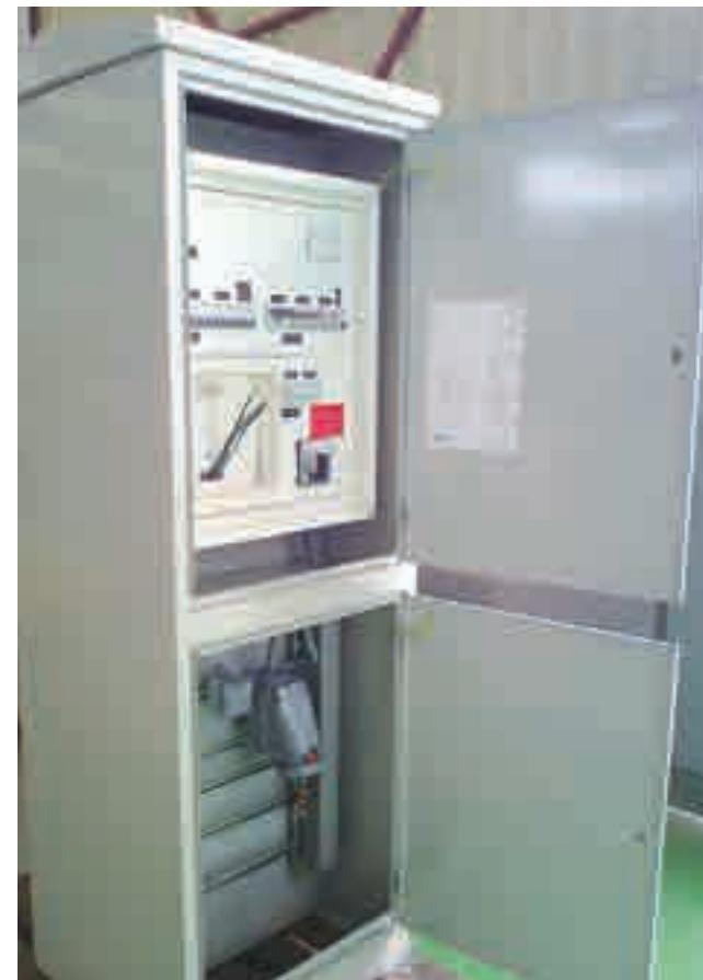
Différentes solutions d'armoires pour télécommunications, Outdoor et Indoor. Pour héberger des stations de radiocommunications et des éléments de commande.
